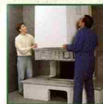
~ 8 Pose de la hotte.
