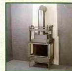
~ 1 Pose du corps de chauffe.
