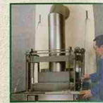
~ 5 Pose de la suspension métallique.
